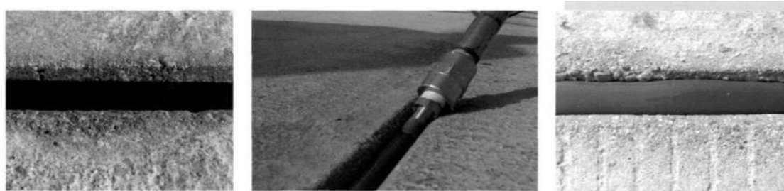
3-rasm. Sementbeton qoplamali choklarni germetizatsiyasining ko'rinishi
