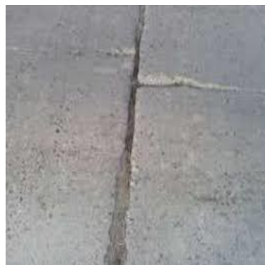
2-rasm. Sementbeton qoplamadagi yoriqlar
