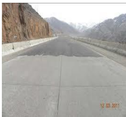
2-rasm. Sementbeton qoplamadagi yoriqlar
