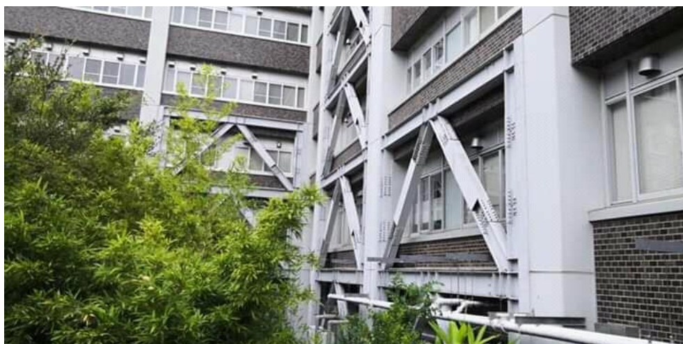
9-расм. Бинонинг каркасига ўрнатилган фрикцион демпферларнинг ўрнатилиши
