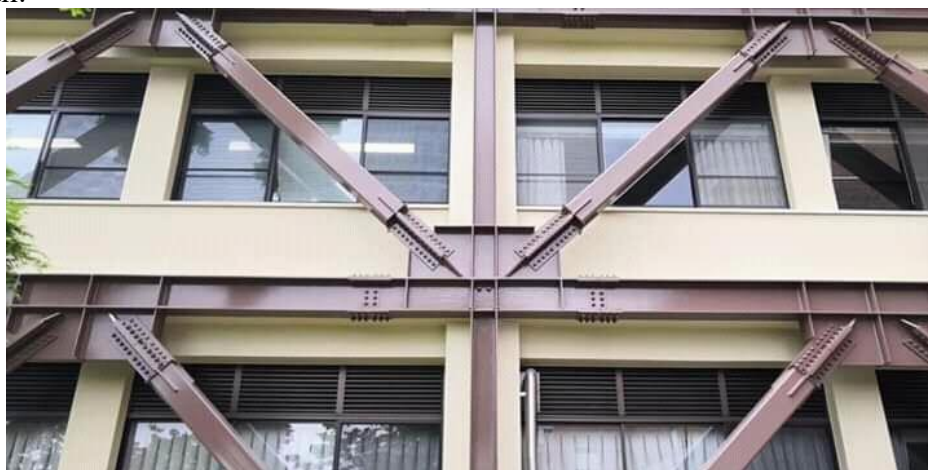
8-расм. Бинонинг фасад қисмига ўрнатилган фрикцион демпферларнинг ўрнатилиши
