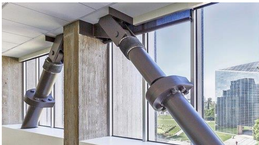
4-расм. Кўп қаватли бинонинг устунларига демпфер қурилмасининг ўрнатилиши
