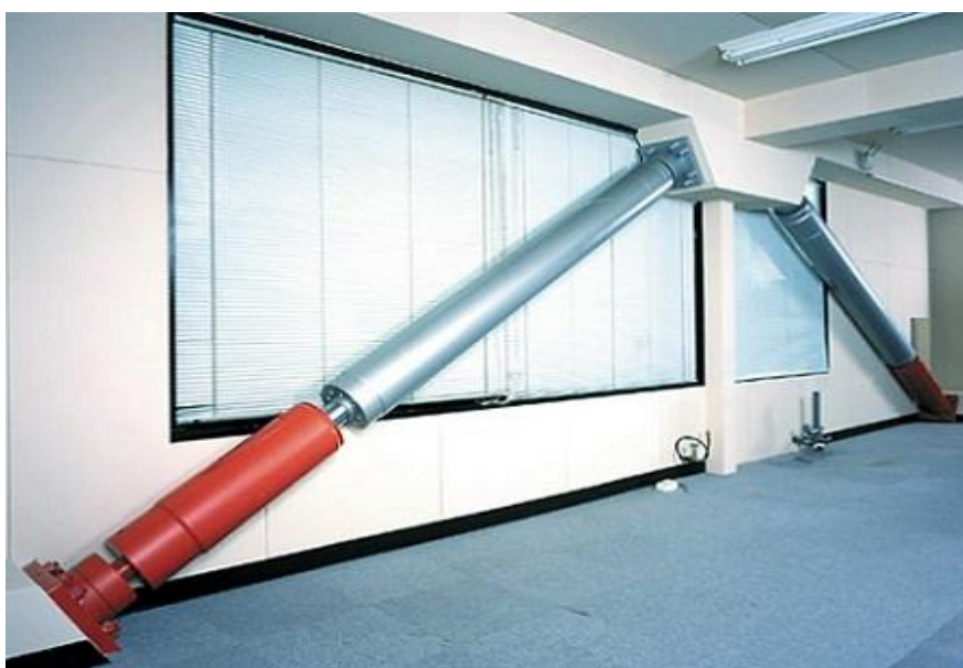
5-расм. Қовушқоқ демпфер қурилмасининг бинонинг ясси рамасига ўрнатилиши
