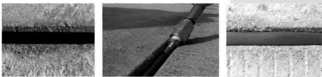
3-rasm. Sementbeton qoplamali choklarni germetizatsiyasining ko'rinishi
