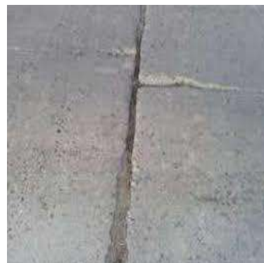
2-rasm. Sementbeton qoplamadagi yoriqlar
