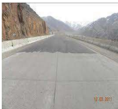
2-rasm. Sementbeton qoplamadagi yoriqlar
